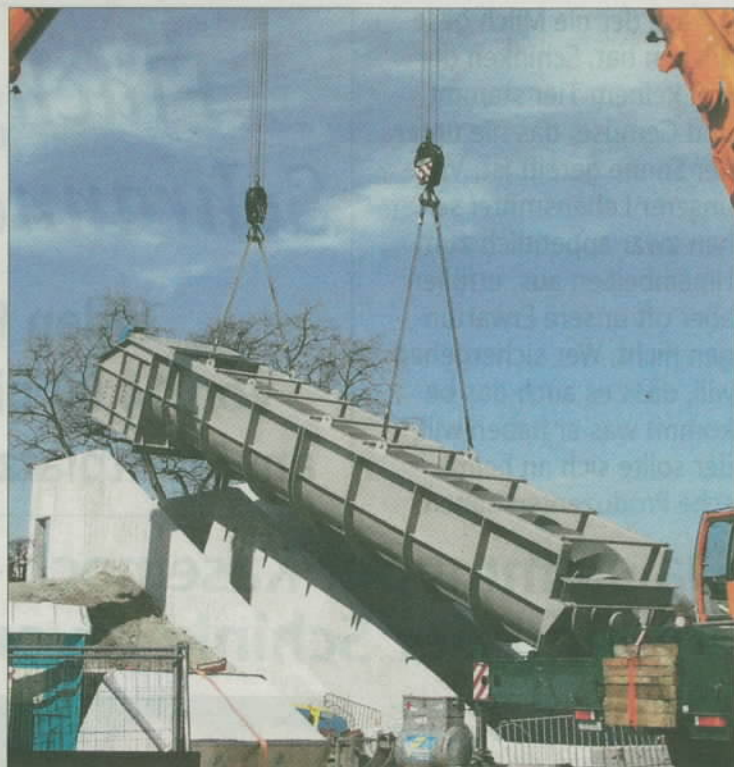
Das Einsetzen der Wasserhebeschnecke war Millimeterarbeit.
