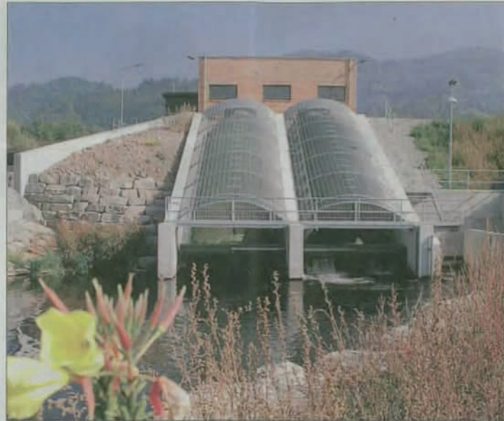
Herzstück des neuen Kraftwerks sind die beiden großen Antriebschnecken für die Generatoren. FOTO: EDGAR STEINFELDER
