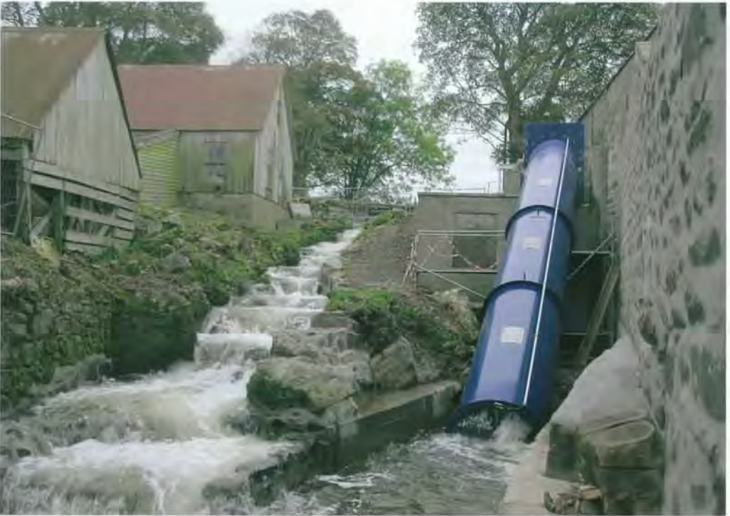
Wasserkraftanlage (Rohrschnecke) in Irland
