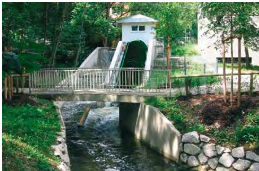
Der Englische Garten in München: Hier am Biederstein ist eine Wasserkraftanlage mit Schnecke im Einsatz, die besonders leise ist. Dadurch kann sie dicht an Wohnhäusern realisiert werden.
