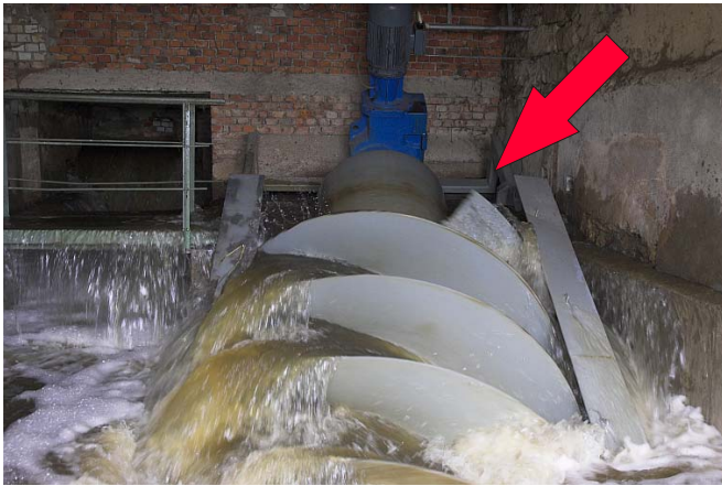
Abbildung 2: Auftauchende erste Schneckenwindung
