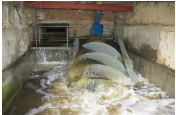
Abbildung 1: Vollständig ins Unterwasser eingetauchte Wasserkraftschnecke
